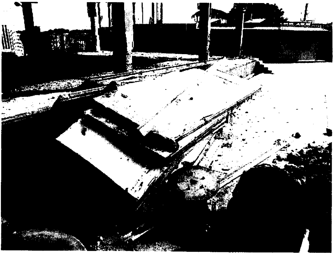
SE APRECIA PUERTAS Y VENTANAS DESMONTADOS
