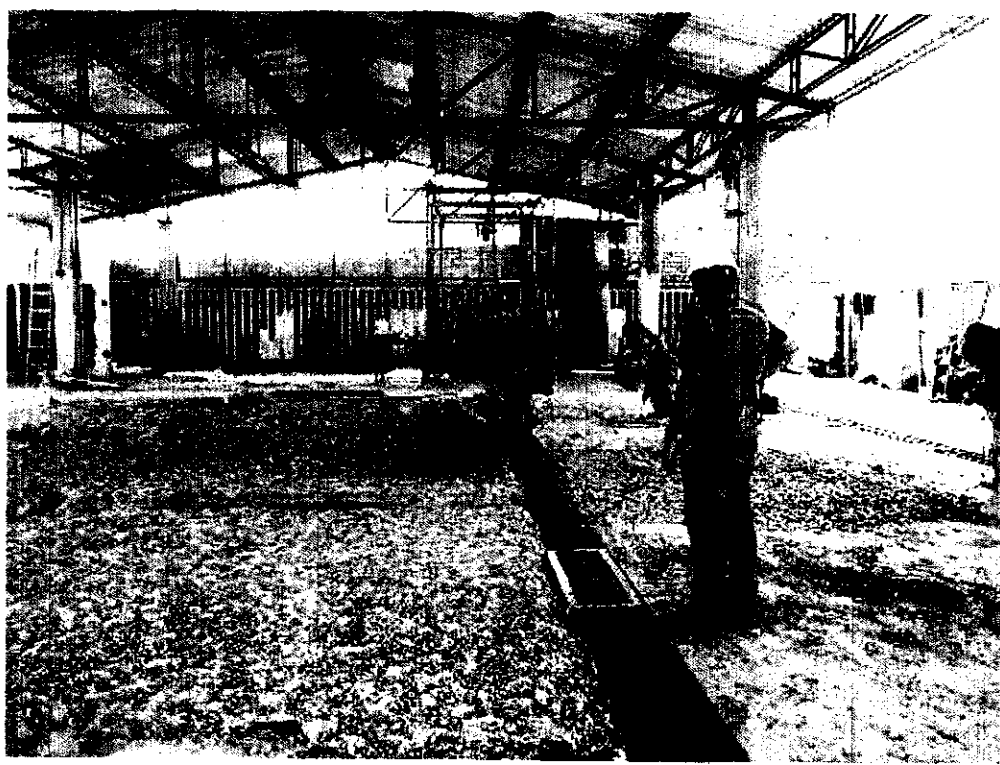
SUPERVISION VERIFICANDO REMOCION DE CANALETAS METALICAS EN MAL ESTADO
